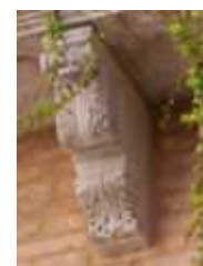
ELEMENTO ARCHITETTONICO CHE HA LO SCOPO DI SORREGGERE ALTRI ELEMENTI COME ARCHI, BALCONI E COLONNE. IN GENERE, VIENE INTEGRATA NEL MURO
